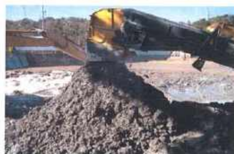
池の堆積土改良堤体利用
