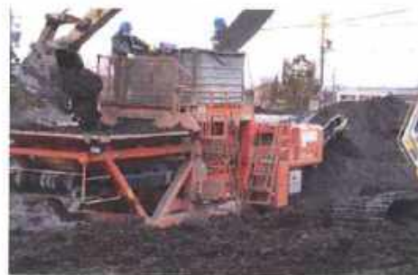
河川浚渫土改良築堤地盤利用
