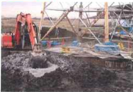
田耕作地の鉄塔基礎工事理め戻し
