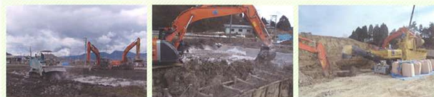
スタビライザーによる 病院駐車場の改良 沈砂池の堆積汚泥の除去 池の改修工事
