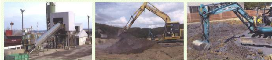
リサイクルプラントでの造粒 建築構造物基礎埋め戻し 宅地盤の安定処理
