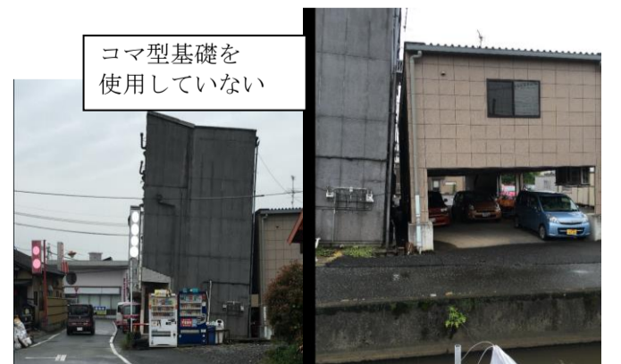
Photo 5. 写真 4 の共同住宅周辺での、コマ型基礎を採用していない建築物の傾斜(液状化被害)
