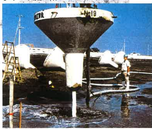
水中コマ施工中
