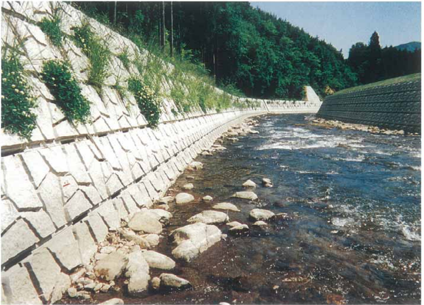
公共河川等災害関連事業工事 岐阜県吉城郡古川町殿川
