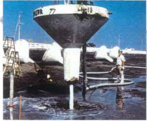
水中コマ施工中
